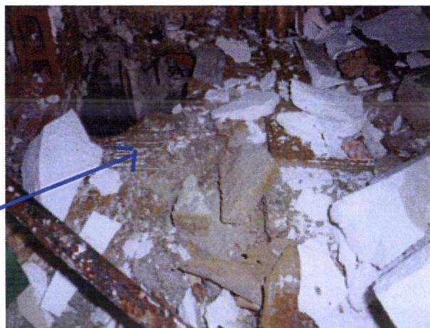
Visuels sur colle de ragréage contenant de l'amiante.
